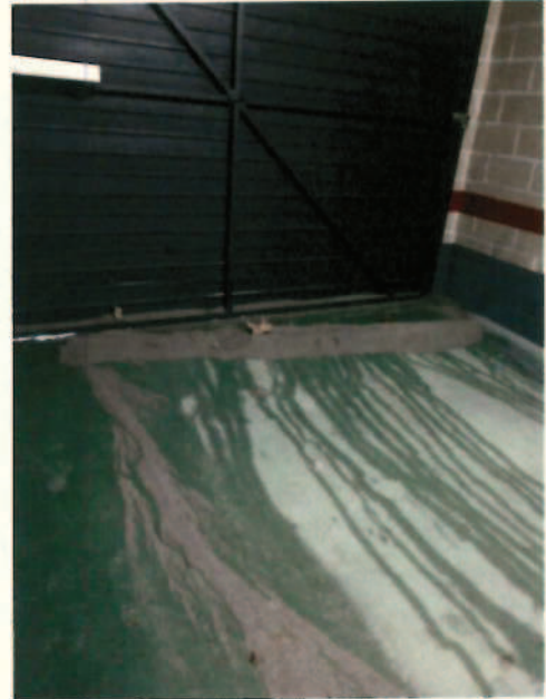
Vista de la porta d'accés a l'aparcament del soterrani -1 de Glòries.
