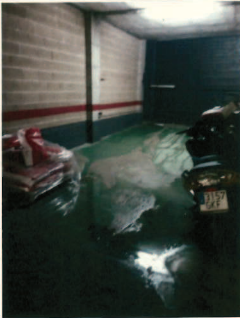
Entrada d'aigua procedent la rampa d'accés de la porta d'aparcament del soterrani -1 de Glòries.
