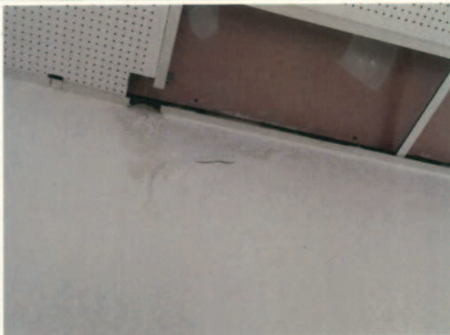
Entrada d'aigua procedent la rampa d'accés de la porta d'aparcament del soterrani -1 de Glòries.
